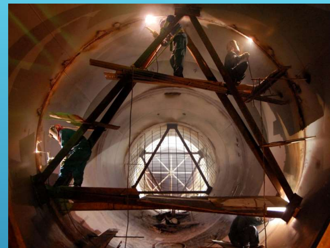
Lắp đặt ống tuần hoàn Thủy điện Đại Ninh / Installation Circulation Water Piping for Dai Ninh Hydropower Plants
