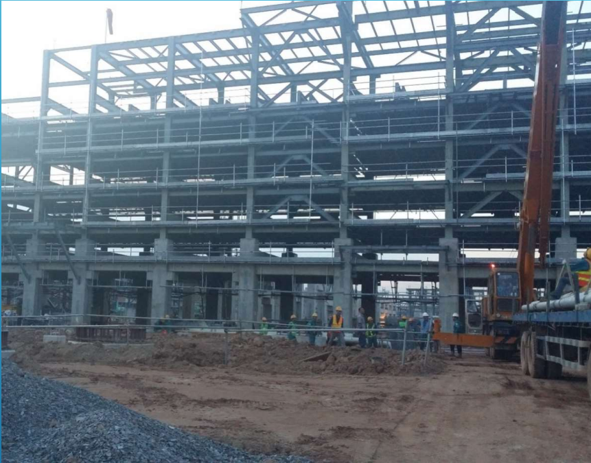
Lắp đặt kết cấu thép Lọc hóa dầu Nghi Sơn / Installation of Steel Structure for Nghi Son Oil Refinery Plant
