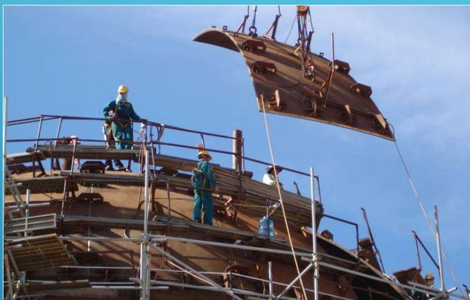
Lắp đặt bồn hình cầu DAP2 / Installation of Spherical tanks for DAP2
