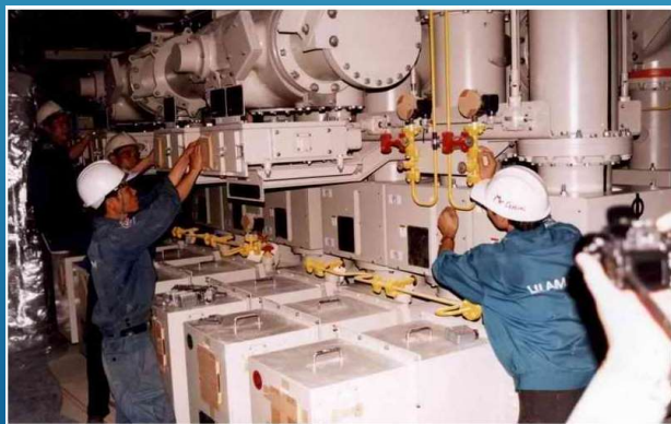
Lắp đặt thiết bị nhà máy thép / Installation of Equipment for Steel plants
