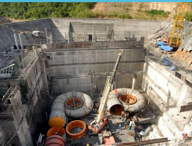
Lắp đặt buồng xoắn Thủy điện Đồng Nai 4 / Installation of Spiral Chamber for Dong Nai 4 Hydropower Plants
