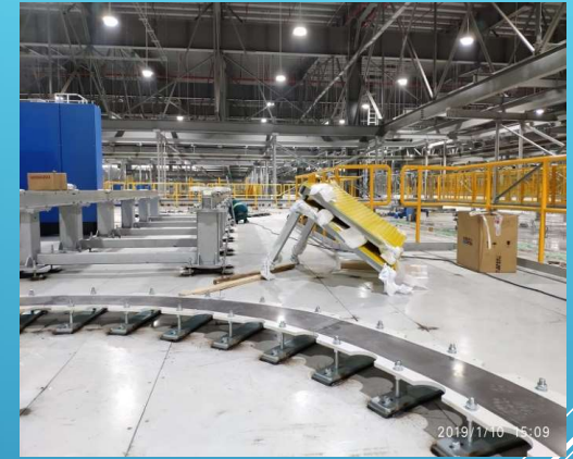
Nhà máy ô tô Vinfast – Lắp đặt bàn xoay / Vinfast automobile factory – Installation lift station
