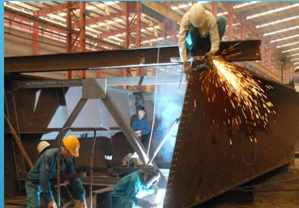
Cầu Thủ Đức / Thu Duc Bridge
