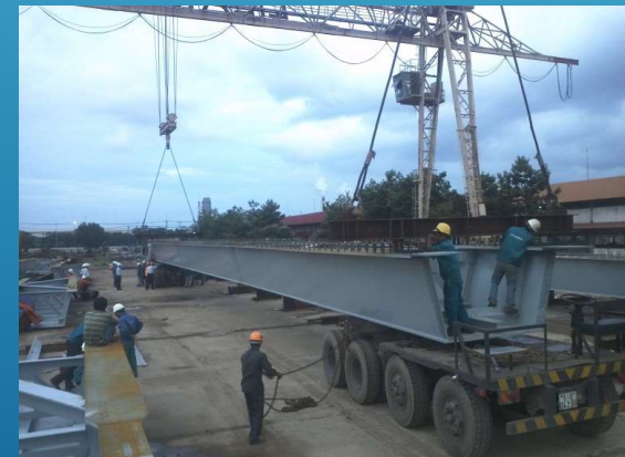
Cầu Hoàng Hoa Thám / Hoang Hoa Tham Bridge
