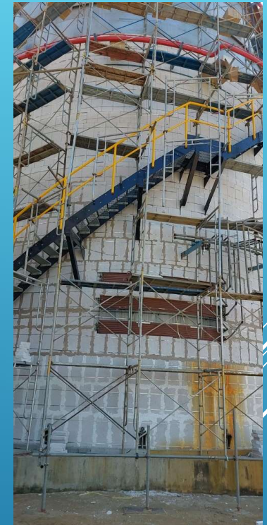
Công việc bảo ôn / Insulation work
