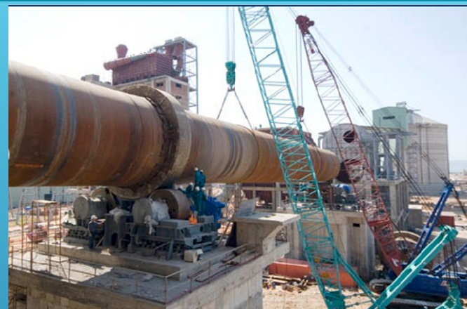
Lắp đặt thiết bị nhà máy xi măng / Installation of Equipment for Cement plants
