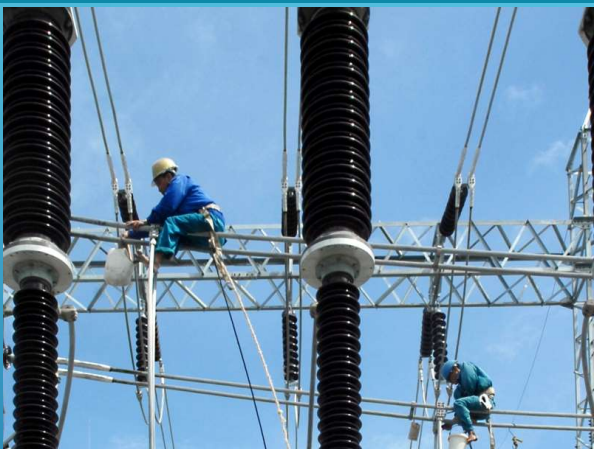
Chế tạo cột thép mạ kẽm/ Fabricated galvanized steel poles & wiring
