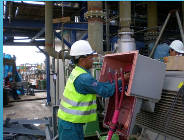
Đấu nối cáp trung thế 6.6 KV với tủ điện / Connecting of medium voltage cable 6.6KV to switchboard
