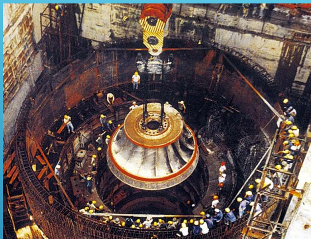
Lắp đặt Turbine Thủy điện Trị An / Installation of Turbine for Tri An Hydropower Plants
