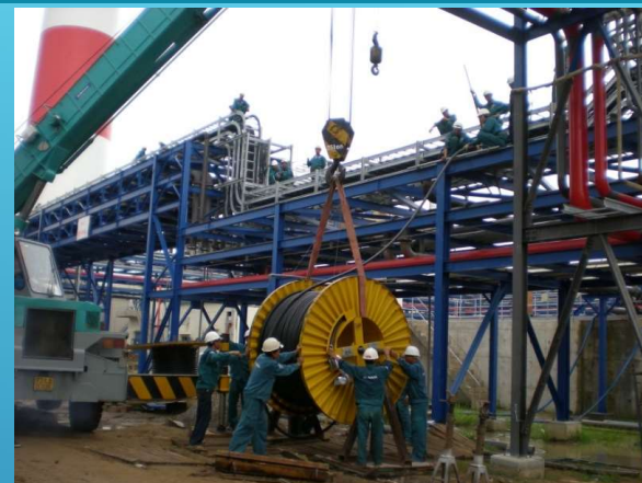
Lắp đặt hệ thống cơ điện, hệ thống nhiệt điện/ Installation of electrical mechanical system, thermosatic system
