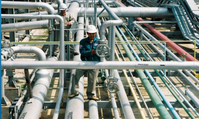
Chế tạo và lắp đặt hệ thống ống / Fabrication & Installation of Piping system
