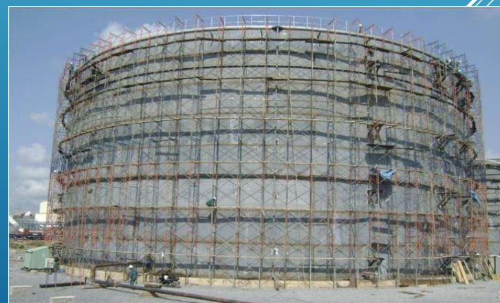
Chế tạo & lắp đặt bồn chứa tiêu chuẩn API/ Fabrication & Installation of API tanks
