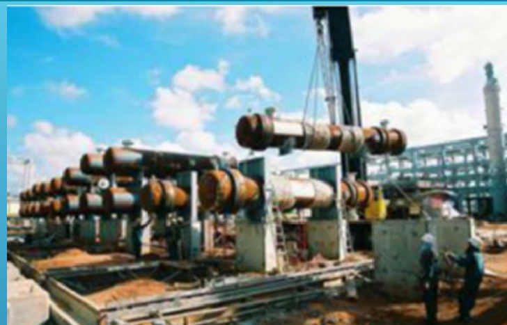
Lắp đặt thiết bị nhà máy đạm / Installation of Equipment for Fertilizer plants
