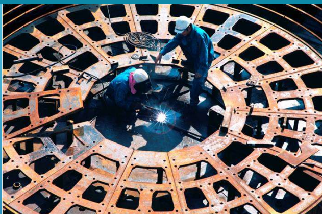
Chế tạo thiết bị cho nhà máy xi măng / Fabrication of Equipment for Cement plants
