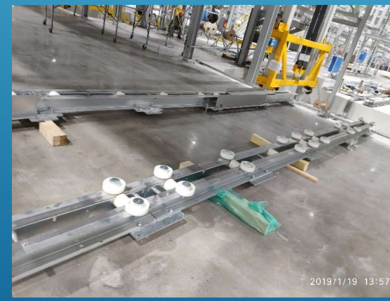
Nhà máy ô tô Vinfast Tổ hợp sàn skilet / Vinfast automobile factory – assembly skilet platform
