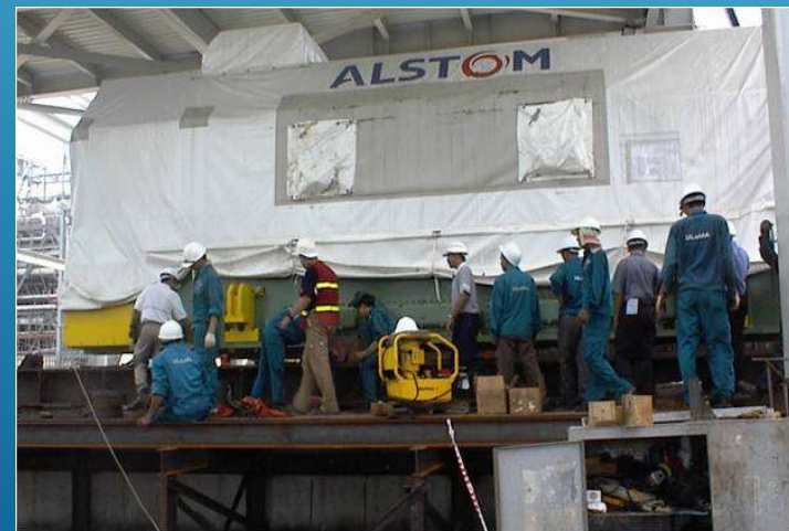
Lắp đặt máy phát nhà máy điện / Installation of Generator for Thermal power plants
