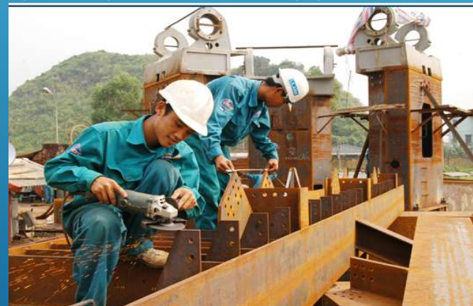
Chế tạo, lắp đặt thiết bị nhà máy thép / Fabrication & installation steel structure for Steel plants
