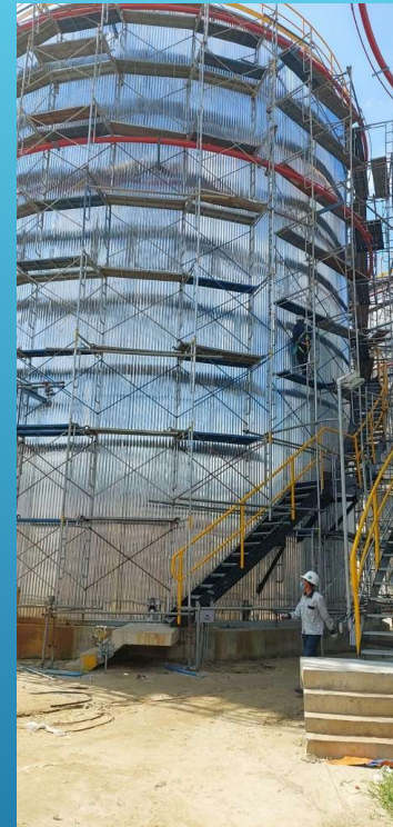
Công việc bảo ôn / Insulation work
